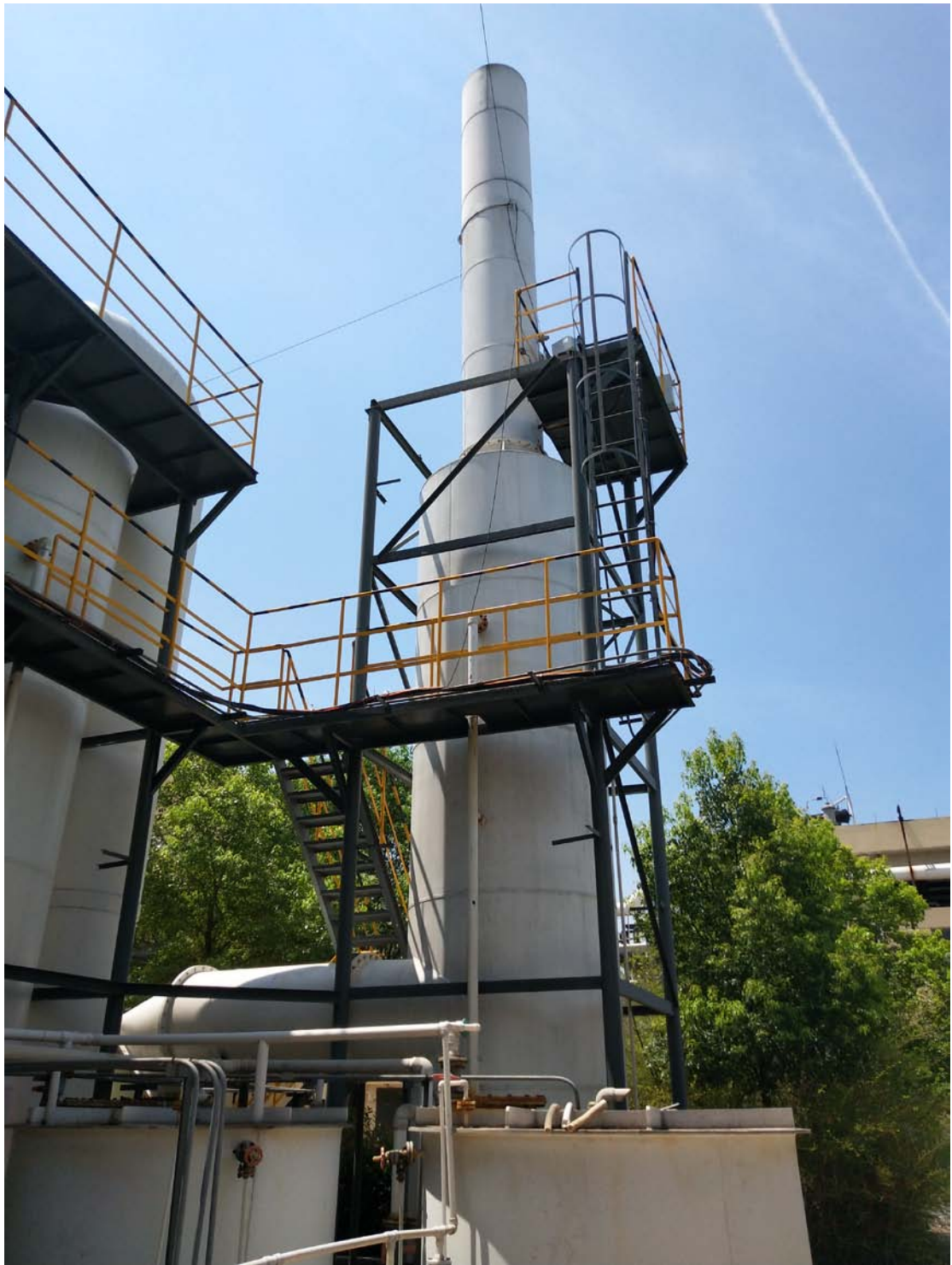
附图 5 废气综合处理装置
